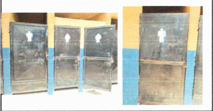
FOTO 6: MODULO 3, mantenimiento y susticion de puertas
