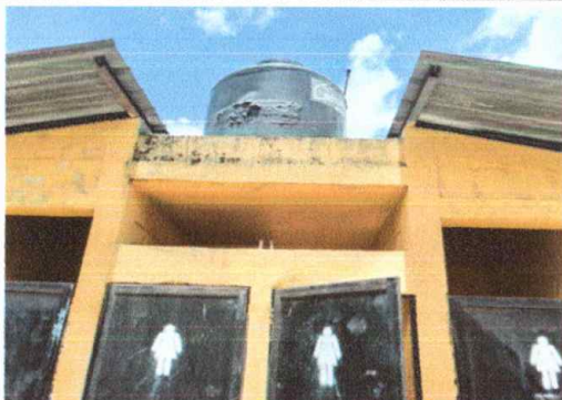
FOTO 7: Módulo 3, sustitución de deposito de agua 2500 Litros
