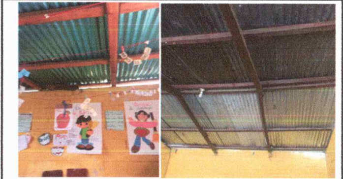
FOTO 2: Módulo 1, sustitucion de estructura de soporte de madera por metal
