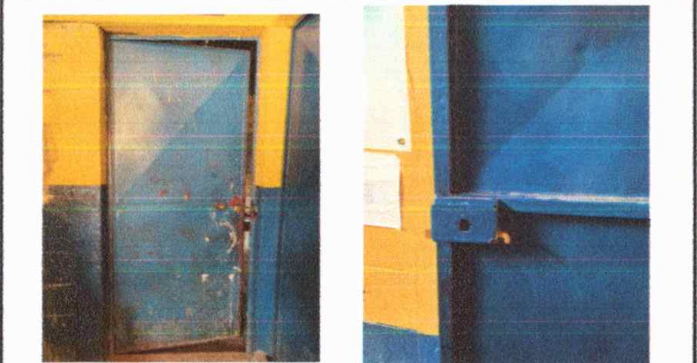
FOTO 3: Módulo 2, sustitucion de chapas y mantenimiento de puertas
