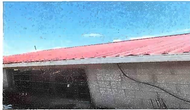
Foto 2: Sustitución de canal PVC
