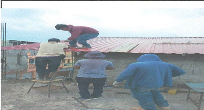
Foto 3: colocación de lamina troquelada
