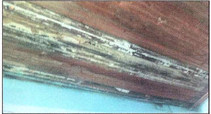
Foto 4: CAMBIO DE MACHIMBRE EN AULAS
