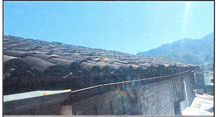
Foto 2: CAMBIO DE TEJA POR LAMINA TROQUELADA
