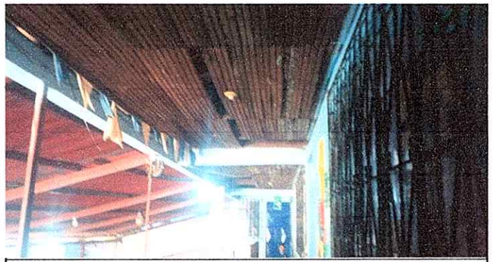
Foto 6: CAMBIO DE MACHIMBRE EN EL CORREDOR
