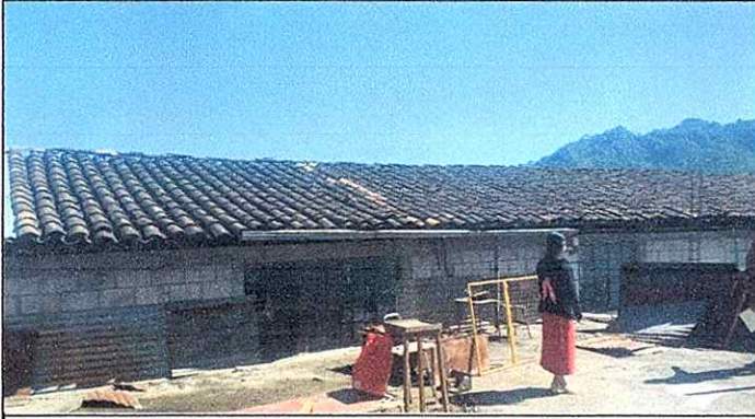
Foto 1: CAMBIO DE TEJADO
