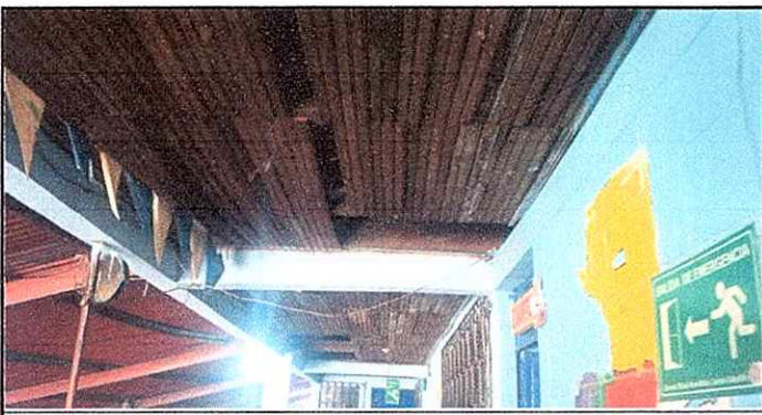
Foto 5: CAMBIO DE MACHIMBRE EN EL CORREDOR
