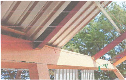
FOTO 1: SUSTITUCION DE LAMINAS TROQUELADAS
