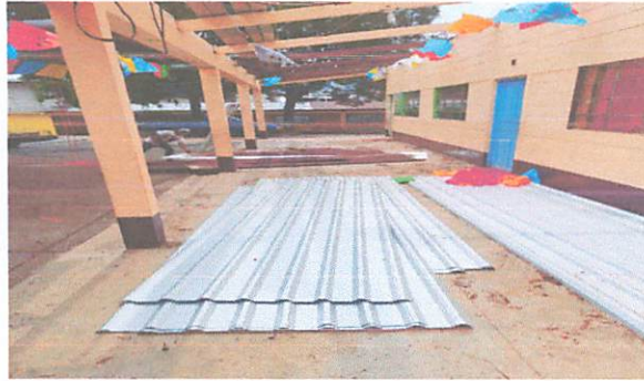
FOTO 2: SUSTITUCION DE LAMINAS TROQUELADAS
