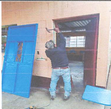
FOTO 3: SUSTITUCION DE PUERTA DE METAL
