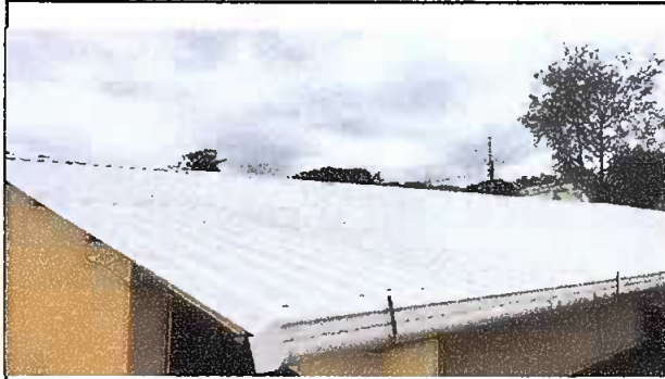
MODULO I Foto1: Sustitución de lámina troquelada
