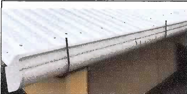
Foto 3 Reparación de estructura de soporte
