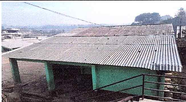
Módulo 2 Sustitución de lámina
