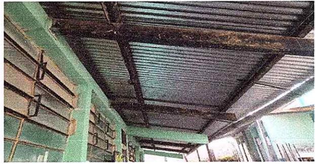
Módulo 1 Sustitución de canales
