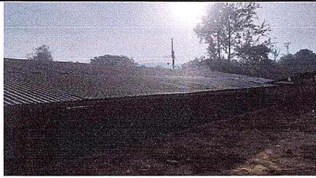
Módulo 1 Sustitución de láminas
