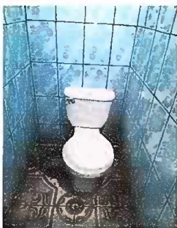
Foto 5: Sanitario de hombres cambiados
