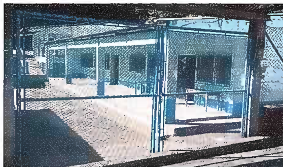
Foto 3: Mantenimiento de porton
