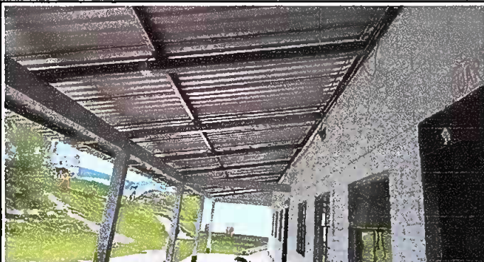
Foto 3: ESTRUCTURA DE METAL PRIMER MODULO
