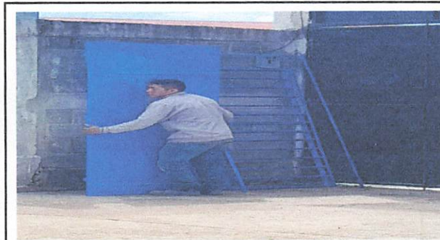
Foto 3: SUSTITUCIÓN DE PUERTAS EN SERVICIO SANITARIOS
