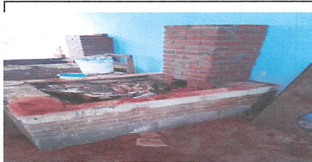
Foto 5: SUSTITUCIÓN DE AZULEJO EN ESTUFA RURAL
