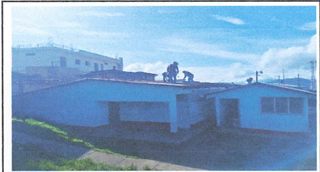
Foto 4: SUSTITUCIÓN DE LÁMINAS POR LÁMINAS TROQUELADAS
