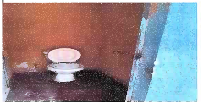
Foto 4: Sustitución de inodoro (BAÑO "A")
