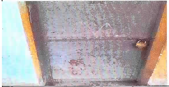
Foto 2: Sustitución de puertas en servicios sanitarios (BAÑO "A")
