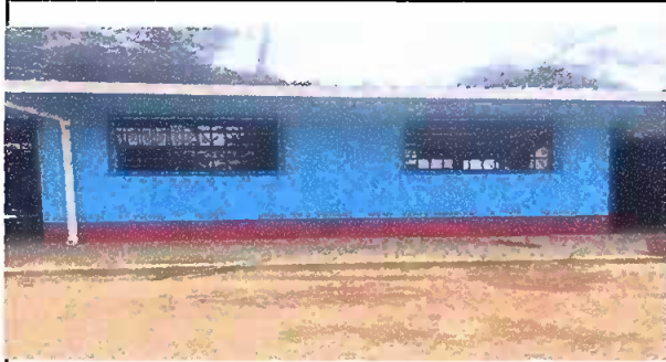
Foto 1: Pintado terminado del modulo 1
