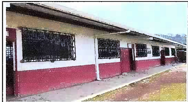
Foto 4: Instalacion de balcones ya terminados modulo 3
