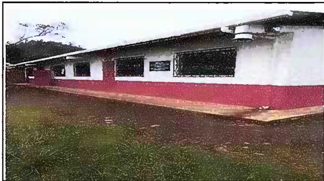
Foto 3: Pintado terminado del modulo 2
