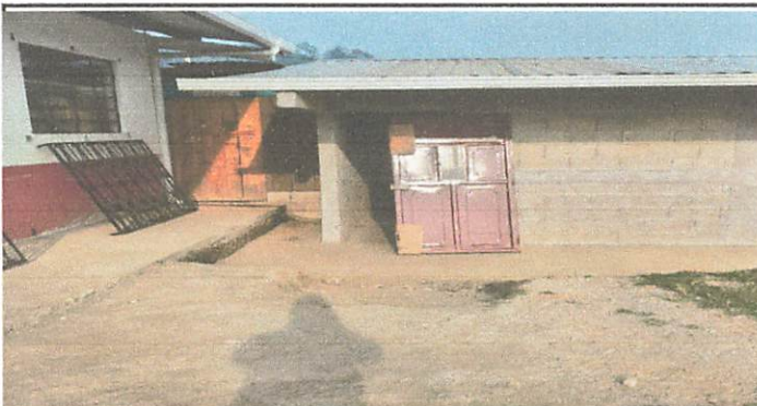
Foto 3: Instalacion de puerta, balcones del modulo 3
