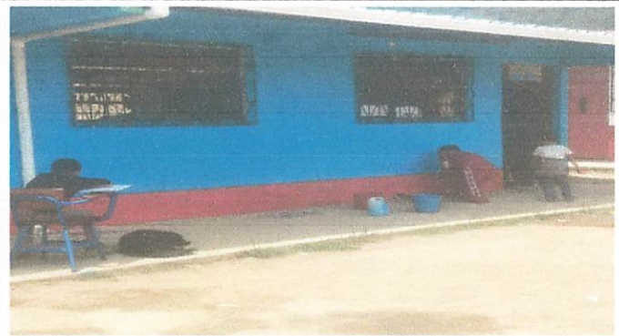
Foto 2: casi terminando de pintar modulo 1
