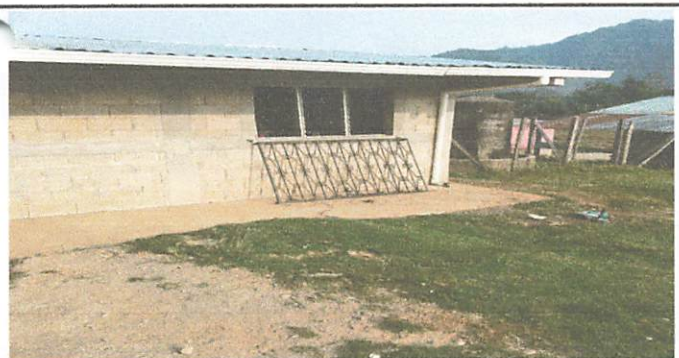
Foto 5: Puesta de ventana y balcones
