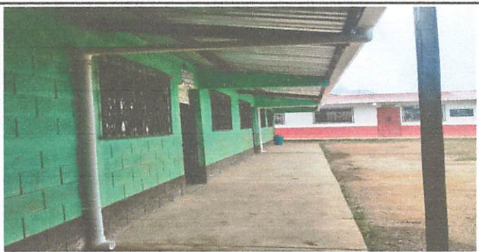
Foto 6: Instalacion de canal y bajada de agua
