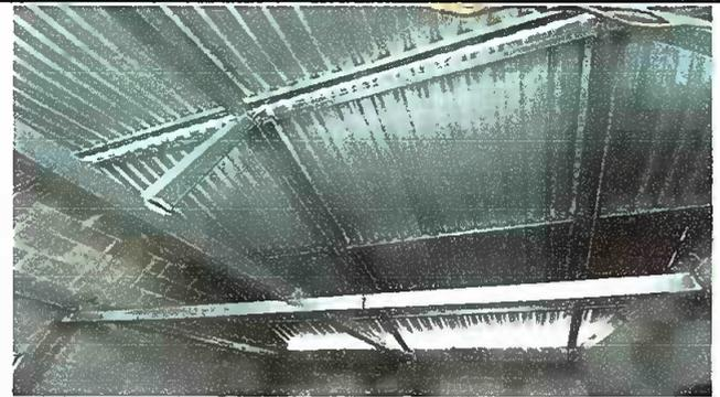
Foto 12: SUSTITUCION DE SOPORTE DE MADERA POR METAL CONCLUIDO
