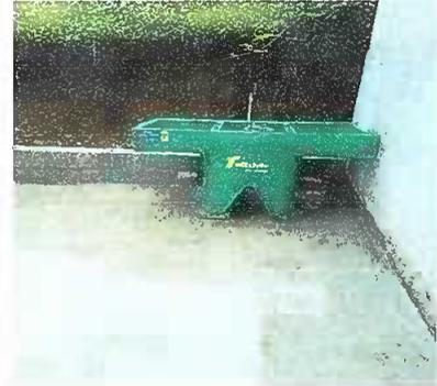
Foto 8: INSTALACION DE UNA PILA PLASTICA DE DOS LAVADEROS
