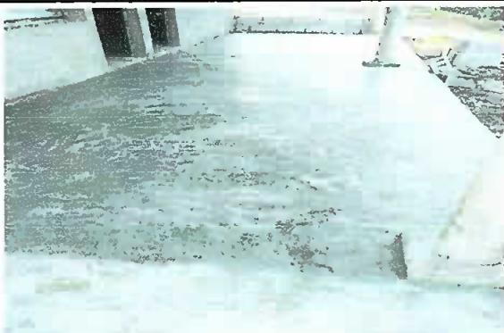
FOTO 15: REPARACION DE PISO TORTA DE CONCRETO EN EL CORREDOR DE LA COCINA
