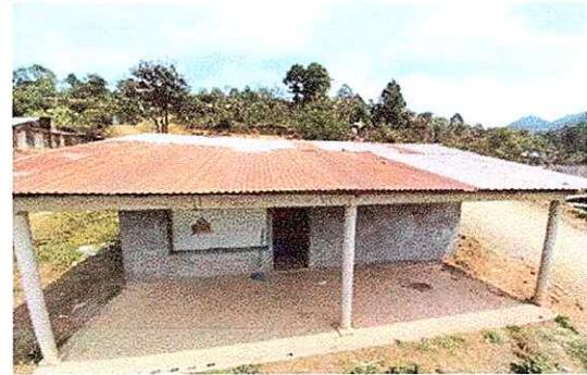
Foto 10: SUSTITUCION DE LAMINA, POR LAMINA TROQUELADA ALUZINC CALIBRE 26
