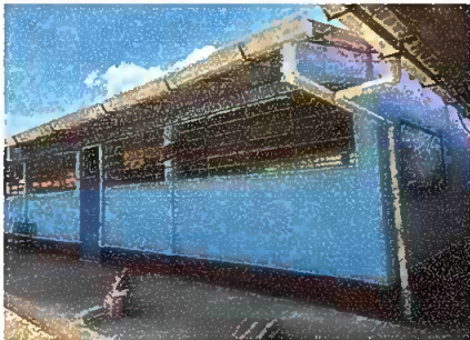
Foto 5. Módulo 1, pintura interior y exterior de aulas
