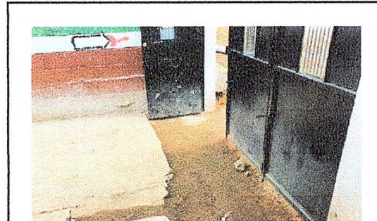
Foto 10. Área exterior, reparación de rampa
