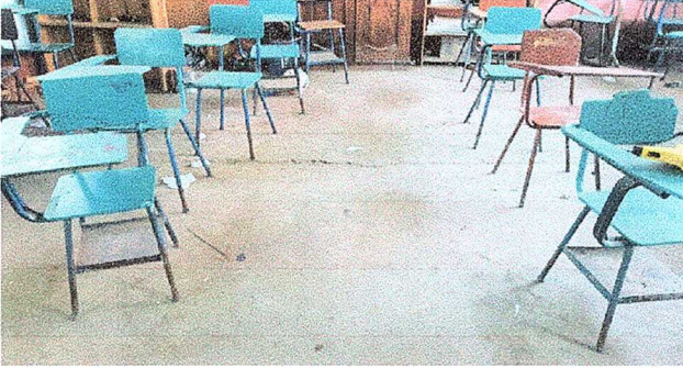
Foto 1: Módulo 1, Sustitución de piso de torta por piso de granito.
