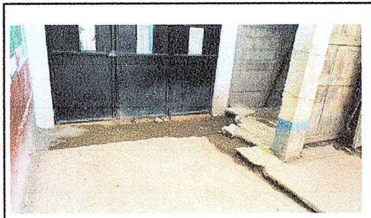
Foto 11. Área exterior, reparación de rampa
