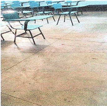
Foto 3. Módulo 2, Sustitución de piso de torta por piso de granito
