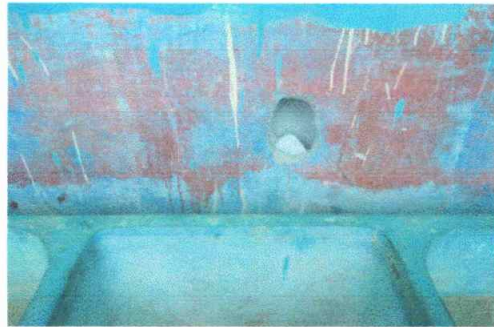
Foto 4: reparacion de pila. Y Asesorios
