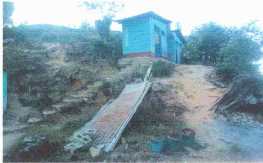
Foto 3: sustitucion de laminas.
