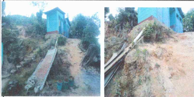
Foto 1: Sustitución de tubería PVC línea principal agua potables y sustitucion de drenaje y Pluvial. Compra de bomba de agua.
