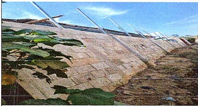
Foto 1: pared ya existente
