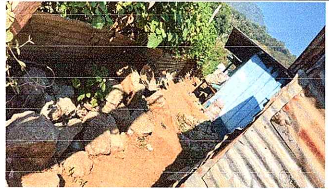
Foto 2: sustitucion con paredes de blok
