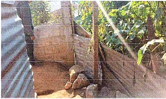
Foto 3: Sustitucion de pared de blok
