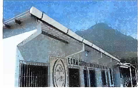
Foto 2: Sustitución de canal de PVC
