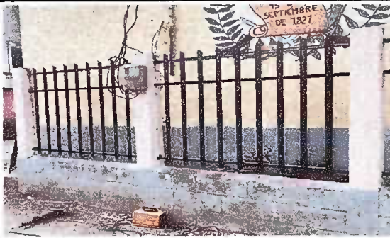
FOTO 3: SUSTITUCION DE BARANDAS
