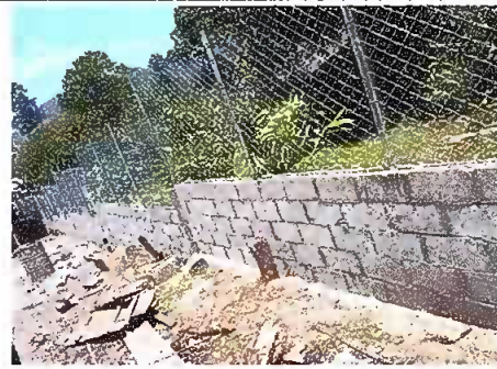
FOTO 4: REPARACION DE MURO PERIMETRAL DE BLOCK
