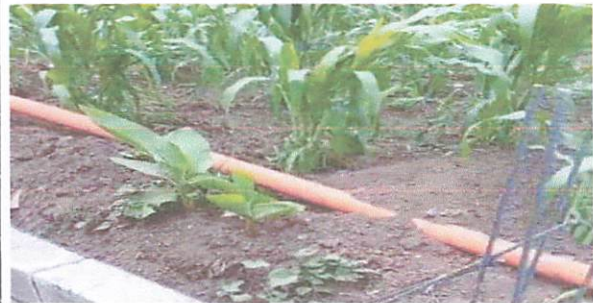
Foto 2: Sustitución de tuberías PVC línea principal aguas negras
