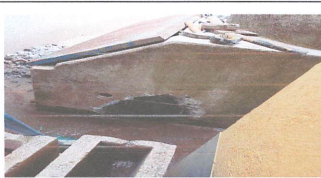
Foto 3: Sustitución de caja de registro
