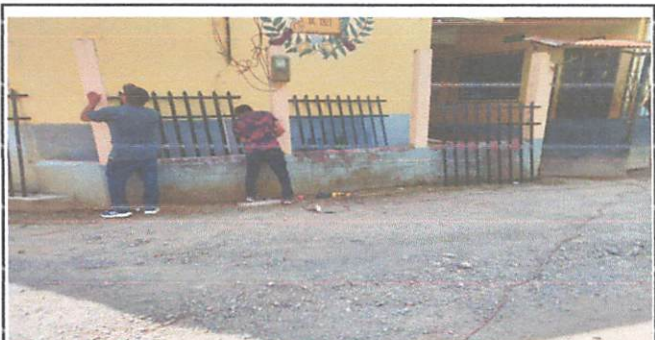
Foto 6: Mantenimiento de portón de metal
