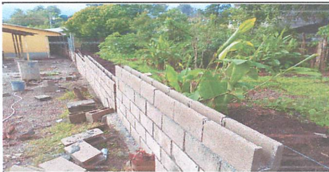
Foto 5: Sustitución de muros perimetrales
