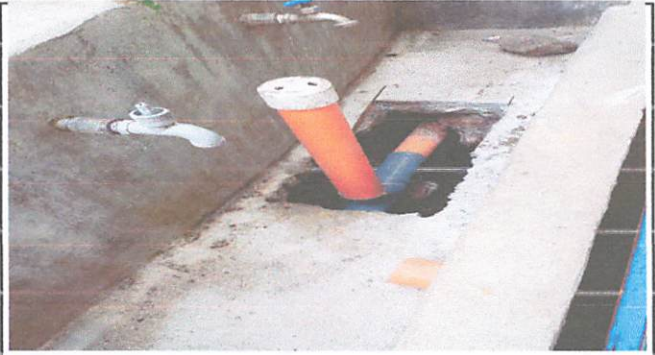
Foto 4: Sustitución de accesorios de deposito de agua
