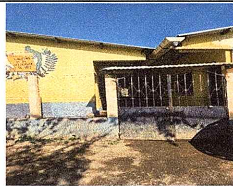
Foto 6: Mantenimiento de portón de metal
