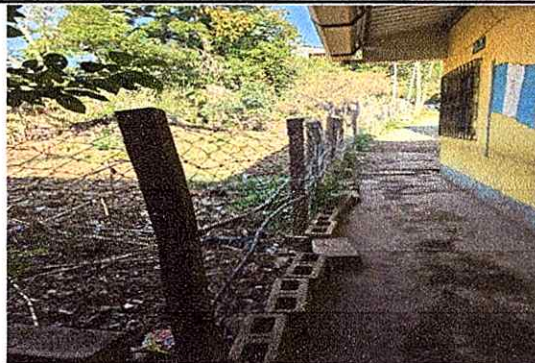
Foto 5: Sustitución de muros perimetrales
