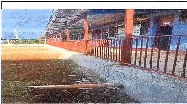
Foto 3: Suministro e Instalación de barranda de metal
