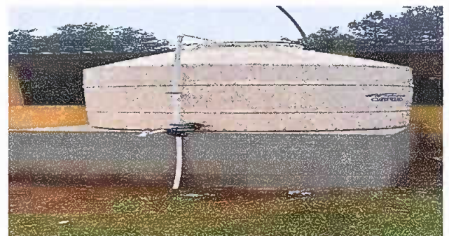
Foto 4: Sustitución de deposito de agua 2500 lt
