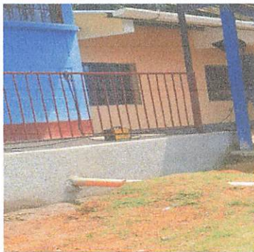
Foto 3: Suministro e Instalación de barranda de metal
