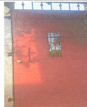
Foto 6: Sustitución de puerta de metal
