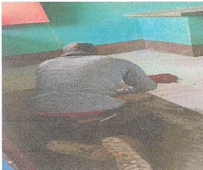
Foto 5: Sustitución de piso cerraamico
