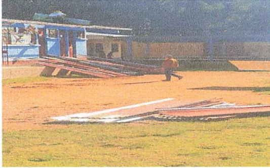
Foto1:Sustitución de lámina por lámina troquelada aluzinc calibre 26 .
