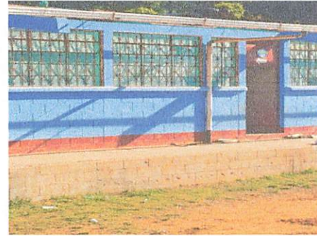
Foto 2: Reparación de bajada de agua pluvial, tubo PVC 3
