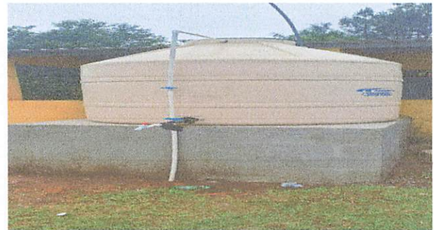
Foto 4: Sustitución de deposito de agua 2500 lt
