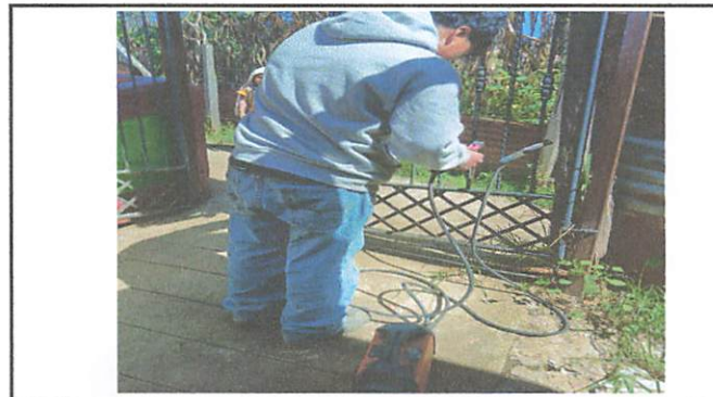
Foto 6: Sustitución de puerta
