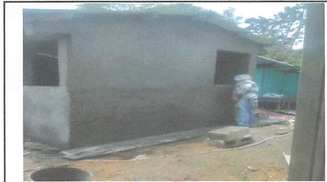
Foto 3: Ampliación de la cocina.
