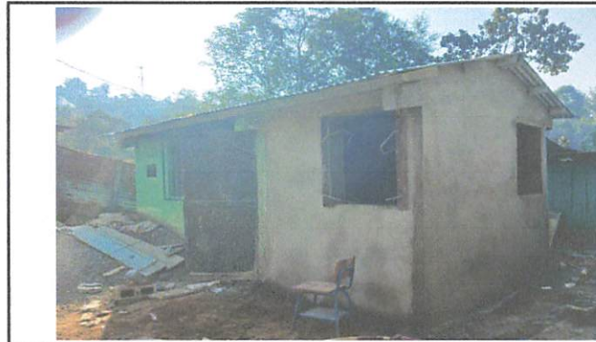
Foto 4: Complemento de patio.
