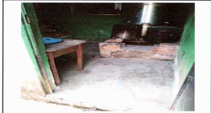
Foto 2: Módulo I Sustitución de estufa
