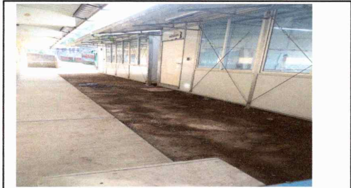
Foto 3: Modulo II Reparación de planchas de concreto de patio
