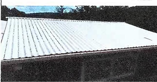
Foto1: Sustitución de laminas troquelada Aluzinc, Capotes, elementos de fijación, sustitución de canales y tubos bajada de agua pluvial.
