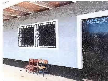
Foto 4: Sustitución de Ventanas de metal mas vidrios, Balcones de metal, puerta de metal
