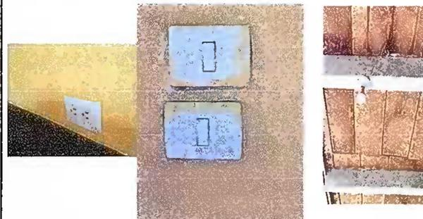
Foto 6: Reparación de cableado, sustitución de plafoneras focos ahorradores tomacorrientes dobles, ductos y calbeado eléctrico.
