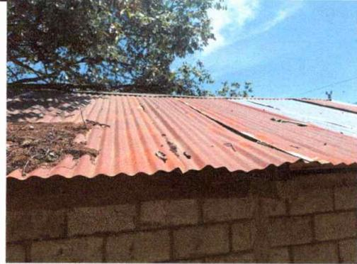
Foto 2: Sustitución de laminas, capotes y elementos de fijación.
