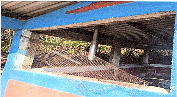
Foto 4: Sustrucción de balcones
