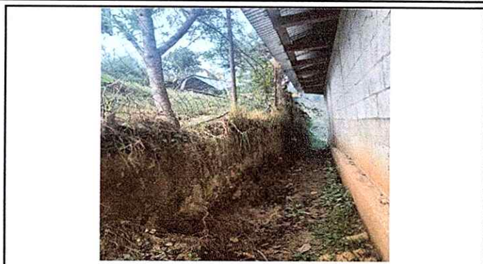
Foto 2: Sustrucción de canales PVC
