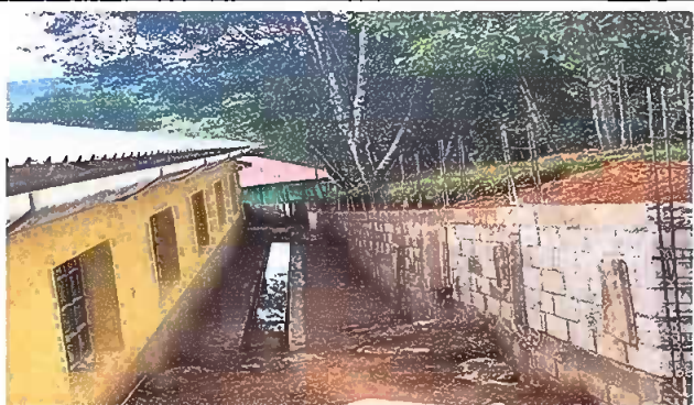
Foto 3: reparacion de muro perimetral de block con tibo hg y malla y galbanizado soleras intermedias y columnas.
