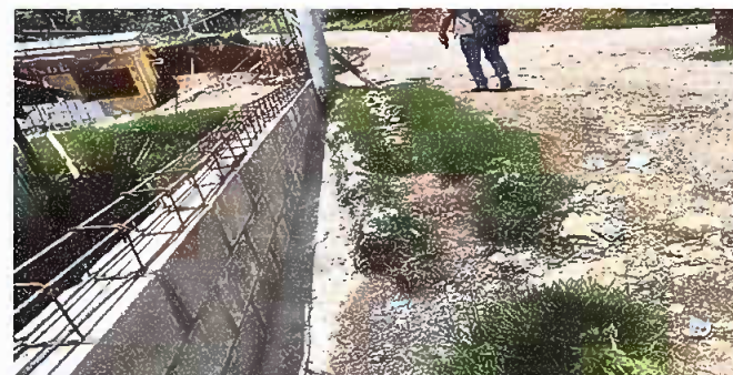
Foto 6: reparacion de muro perimetral de block con tibo hg y malla y galbanizado soleras intermedias y columnas.
