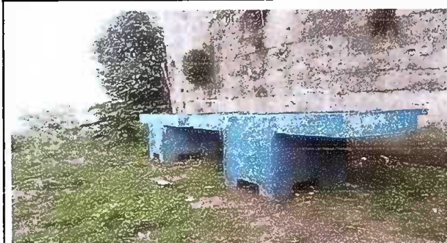
FOTO 4: SUSTITUCION DE DOS PILAS
