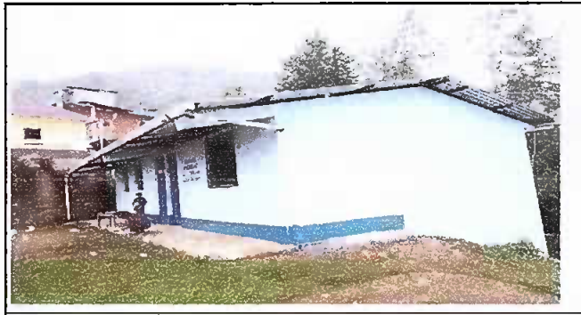
FOTO 6: APLICACIÓN DE PUNTURA EXTERIOR E INTERIOR
