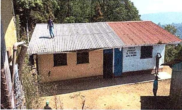
Foto1: Sustitución de lamina a lamina troquelada
