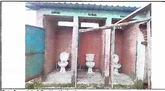
Foto 5: modulo 2 Sustitución inodoro
