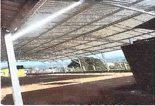
FOTO 1: SUSTITUCION DE LAMINA TROQUELADA CALIBRE 26
