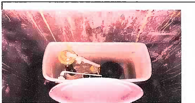
Foto 2: sustitucion de accesorio de inodoro
