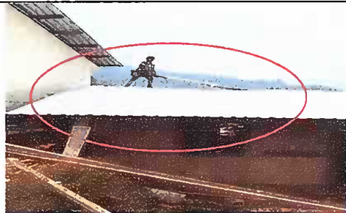
FOTO 3: SUSTITUCION DE LAMINA TROQUELADA
