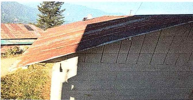
Foto 5: SUSTITUCION DE TECHO DE LAMINA POR LAMINA TROQUELADA ALUCINC CALIBRE 26
