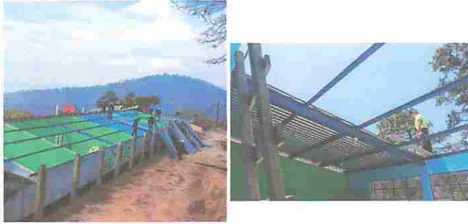
Módulo 1: sustitución de lámina, por lámina troquelada
