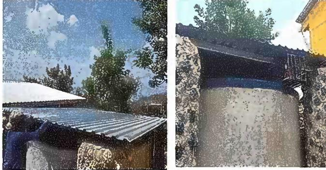
**MODULO 3:** sustitucion lamina troquelada y sustitucion de soporte de madera por metal.
