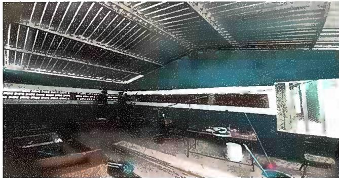
**MODULO 2:** Sustitucion de techo, lamina troquelada, calibre 26
