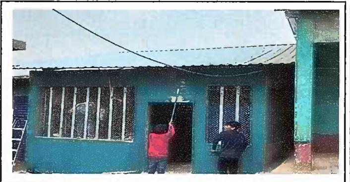
MODULO 2: MODULO 2: Sustitucion de estructura de soporte de madera por metal, y reparacion de muro perimetral de block H 2.40.
