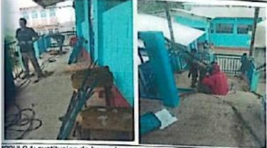
MODULO 1: sustitucion de barandas metal, cambio de parte inferior y cambio de abarrotos.
