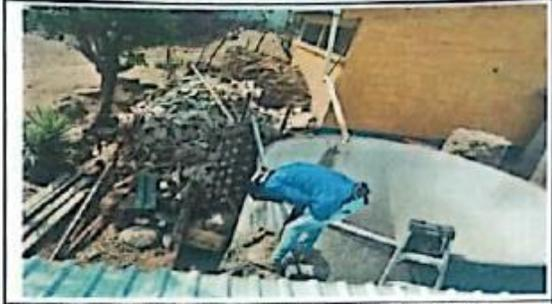
**MODULO 3:** sustitucion lamina troquelada y sustitucion de soporte de madera por metal.
