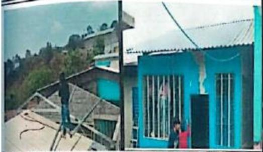
**MODULO 2:** Sustitución de techo, lamina troquelada, calibre 26 y sustitución de soporte de madera por metal.
