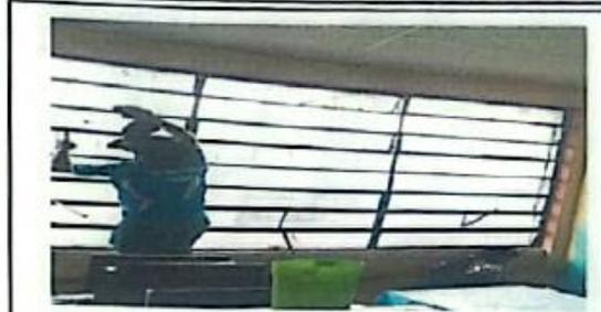
MODULO 1: Sustitucion de vidrios, sustitucion de estructura de metal de ventana.
