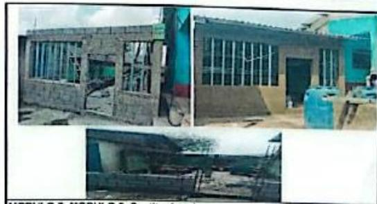
MODULO 2: MODULO 2: Sustitucion de estructura de soporte de madera por metal, y reparacion de muro perimetral de block H 2.40. Mojinete, piso, tallado columnas y repello
