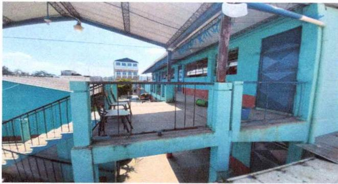
**MODULO 1: sustitucion de barandas metal, cambio de parte inferior y cambio de abarotes.**
