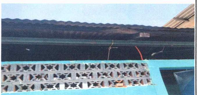
**MODULO 2: MODULO 2: Sustitucion de estructura de soporte de madera por metal, y reparacion de muro perimetral de block H 2.40.**
