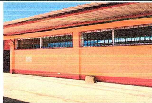
Foto 4: MODULO 1: Suministro e instalación de Balcones de metal
