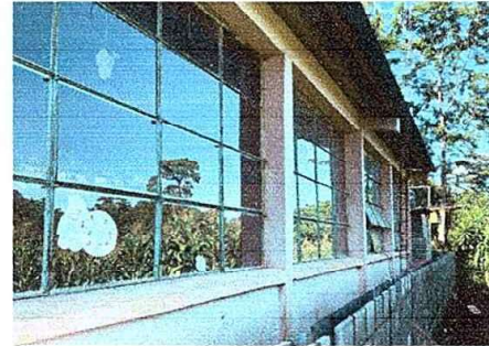
Foto 4: MODULO 1:Suministro e instalación de Balcones de metal
