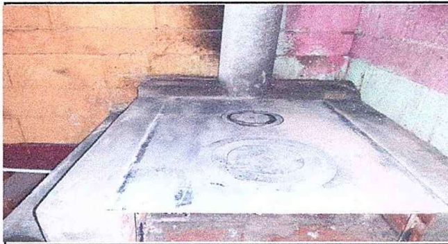
Foto 3: Módulo1 Sustitucion de estufa rural (completa) incluye chimenea y plancha de metal EODP. Anexa a EORM. Aldea Chuaquenum, Joyabaj, Quiché.
