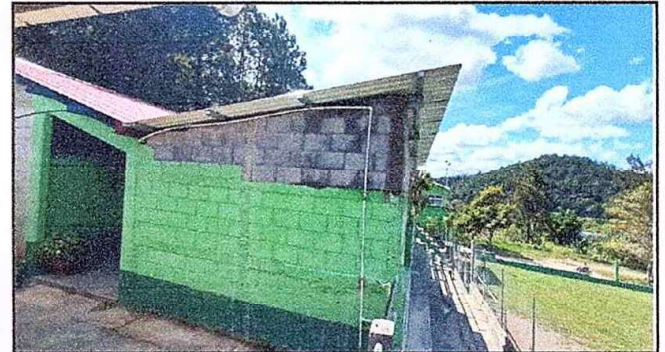
Foto 10: Módulo 1 Levantado de mojinete en cocina. EODP. Anexa a EORM. Aldea Chuaquenum, Joyabaj, Quiché.
