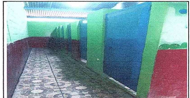
Foto 6. modulo 1 Suministro e instalacion de puerta de metal en baños. EODP. Anexa a EORM. Aldea Chuaquenum, Joyabaj, Quiché.
