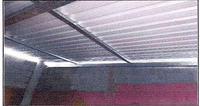
Foto 2: Módulo 1. Sustitucion de estructura de soporte de madera por metal. EODP. Anexa a EORM. Aldea Chuaquenum, Joyabaj, Quiché.
