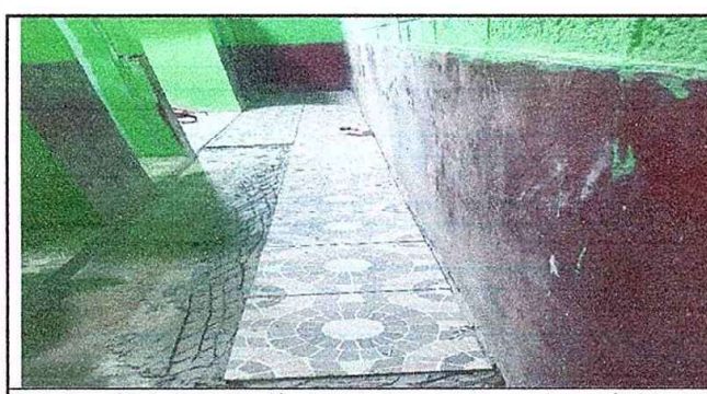
Foto 11: módulo 1 Sustitución de torta de cemento por piso cerámico. EODP. Anexa a EORM. Aldea Chuaquenum, Joyabaj, Quiché.
