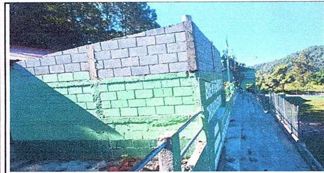
Foto1: Modulo 1 Sustitucion de lámina por lámina troquelada Aluzink. EODP. Anexa a EORM. Aldea Chuaquenum, Joyabaj, Quiché.
