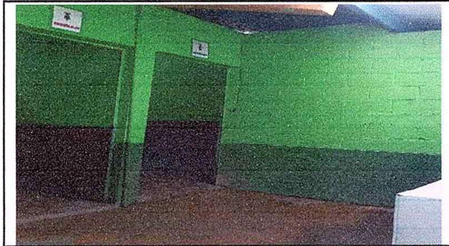
Foto7: Modulo 1 Mantenimiento de puertas de metal en baños. EODP. Anexa a EORM. Aldea Chuaquenum, Joyabaj, Quiché.
