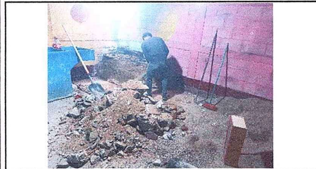
Foto 3: Módulo1 Sustitucion de estufa rural (completa) incluye chimenea y plancha de metal EODP. Anexa a EORM. Aldea Chuaquenum, Joyabaj, Quiché.
