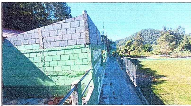
Foto 10: Módulo 1 Levantado de mojinete en cocina. EODP. Anexa a EORM. Aldea Chuaquenum, Joyabaj, Quiché.
