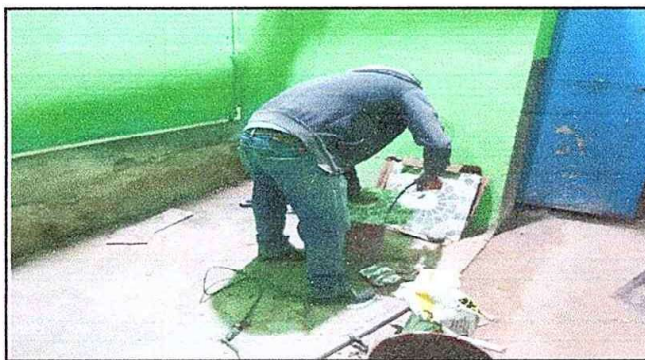
Foto 9: Módulo1 Sustitucion de Migitorios. EODP. Anexa a EORM. Aldea Chuaquenum, Joyabaj, Quiché.
