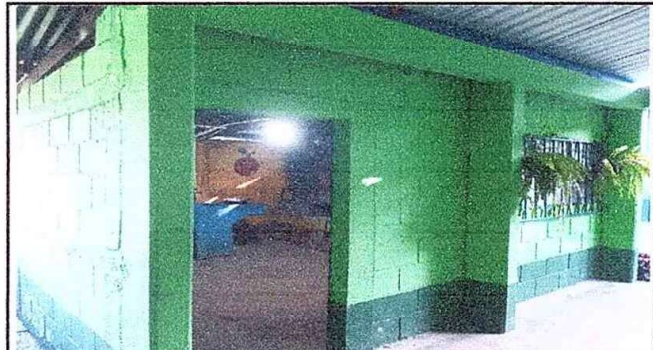
Foto 4: Módulo 1 Sellado de vano. EODP. Anexa a EORM. Aldea Chuaquenum, Joyabaj, Quiché.
