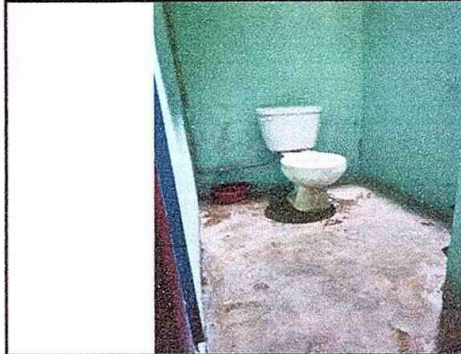
Foto 8: Módulo1. Sustitucion de inodoros. EODP. Anexa a EORM. Aldea Chuaquenum, Joyabaj, Quiché.
