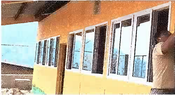
Foto1: Sustitucion de estructuta de metal de ventanas. y Sustitucion de vidrios
