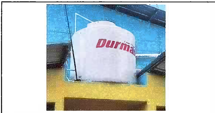
Modulo 3: Sustitución de deposito de agua 1700 lt.
