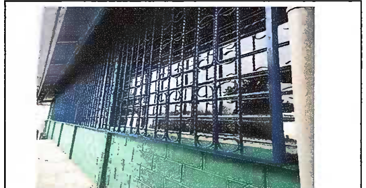
Modulo 2: Fabricación e instalación de balcones en ventana
