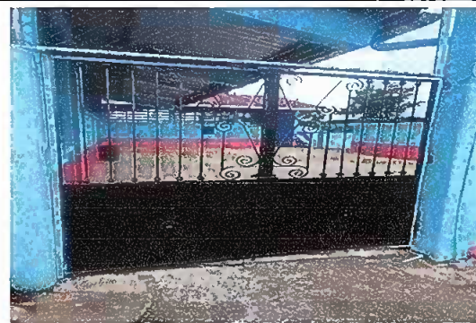
Modulo 5: Sustitución portón de metal.
