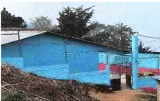
Modulo 5: Pintura en muros exteriores e interiores.
