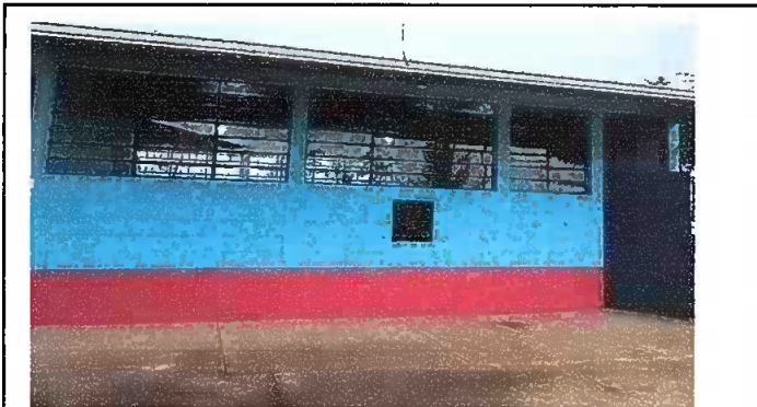
Modulo 1: Pintura en paredes interiores y exteriores de todo el establecimiento.
